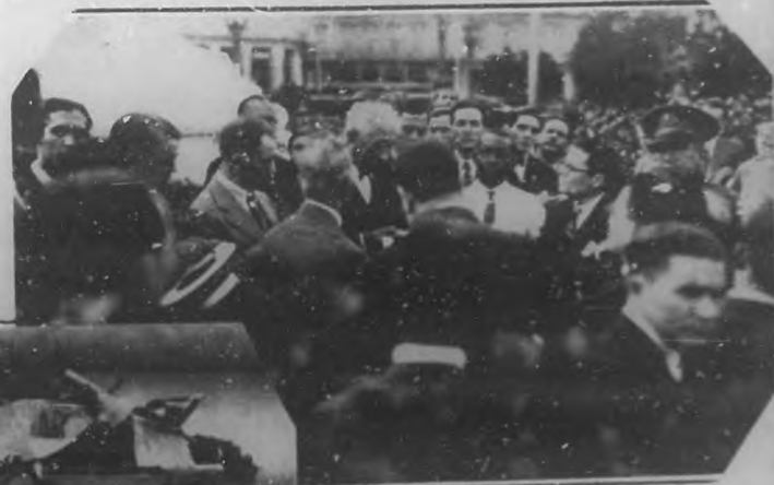
EL HOMENAJE A MARTI. El Presidente de la Sección de Propaganda de la "Asociación Canaria" señor Luis F. GÓMEZ WANGUEMERT, pronunciando breves palabras frente a la estatua del Apóstol, al iniciar la obra de la colecta que durante veintidós días se celebró en honor a Martí.
